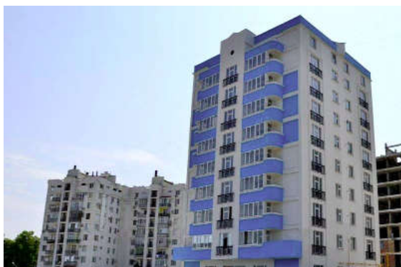
Nhà lắp ghép bằng bê tông cốt thép
