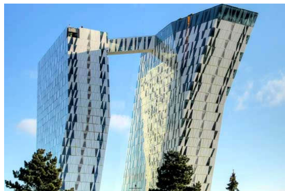
Tòa nhà văn phòng - khách sạn Bella Sky (Copenhagen, Đan Mạch) - công trình độc đáo ứng dụng công nghệ xây lắp ghép
